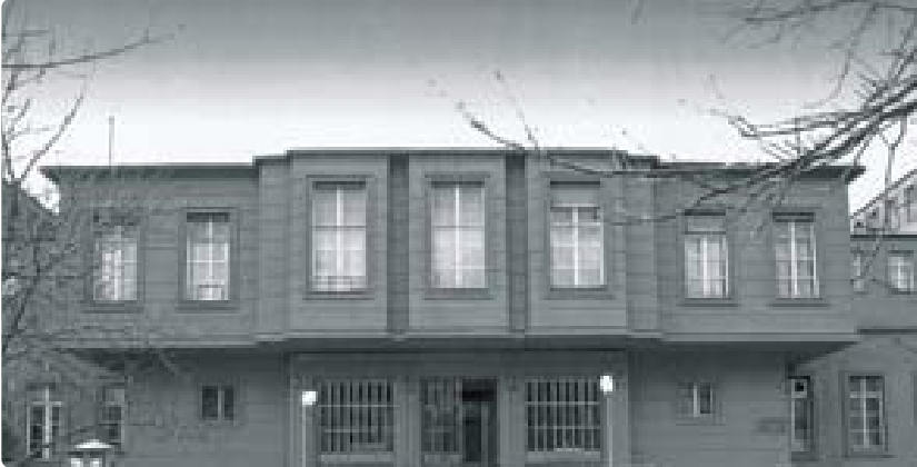
Eski Ticaret Bakanlığı binası
